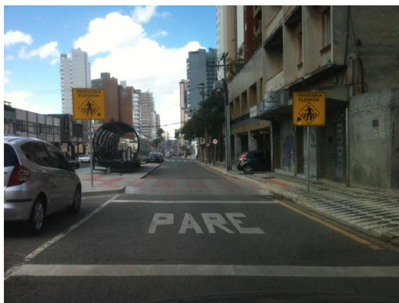
FIGURA 7 – Travessia Elevada em Paver na Av. João Gualberto – Estação Constantino Marochi – Curitiba Pr
