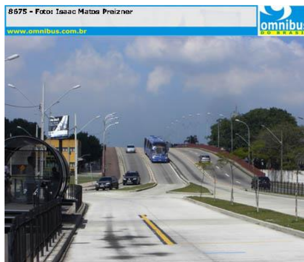
FIGURA 5 - Desalinhamento na Av. Mal. Floriano Peixoto – Estação Tubo Ferroviária – Curitiba Pr
